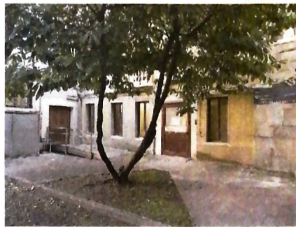
PALAZZINA EX SIT Qui sarà ricavato il residence per i sanitari
